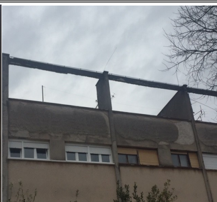
Sjeverna strana fasade
